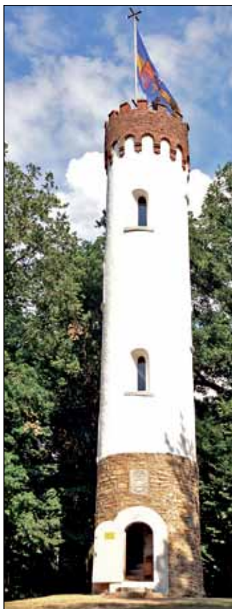
Im vergangenen Jahr wurde der Aussichtsturm umfassend saniert. Fotos: Stadtmedienarchiv
